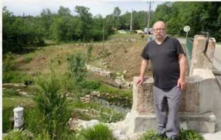
Jean-Paul Duchemin a défriché le site de l'ancienne scierie Meynier, en aval du barrage. Photo Progrès/Olivier FAIVRE
