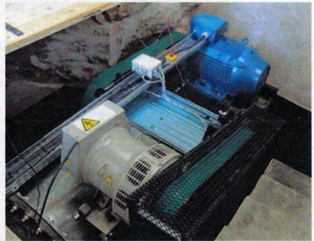
*Moulin d'Amont : ci-contre, détail du barrage ; ci-dessus, intérieur de la microcentrale : de g. à dr., l'extrémité de la conduite, l'alternateur et sa courroie protégée, la turbine (bleu clair), la génératrice asynchrone (bleu plus foncé).*
