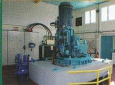
Située sur La Loue, la microcentrale hydro-électrique du moulin de Parcey est construite en 1948 puis automatisée en 1994. Elle est rénovée en 2007. Equipée de deux turbines Kaplan elle a une puissance de 400 kW avec un débit dérivé de 12 mètres cubes/sec et une hauteur de chute de 4 mètres.
